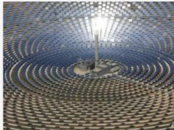
En la naturaleza el girasol distribuye y coloca sus semillas de tal forma que **aprovecha al máximo el espacio** disponible en su superficie. Este principio se ha aprovechado en el mundo de la ingeniería para posicionar los heliostatos de una central termosolar para proporcionar una **mayor producción de energía en un menor espacio**. Gracias a ello se consigue una **mayor eficiencia**.
